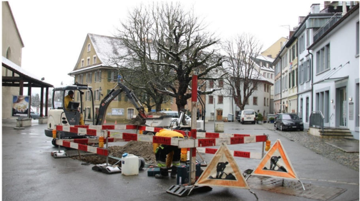
Bauarbeiten mitten in Baden: Auf dem Kirchplatz verlegen Arbeiter Glasfasern. PKR
